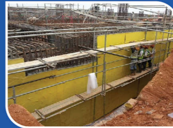
Chống thấm cho hầm
