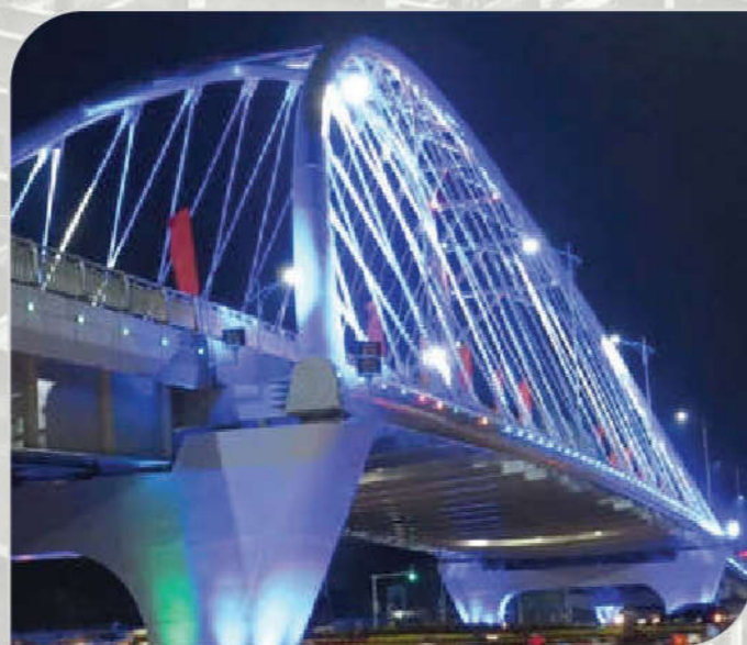
Hệ thống chiếu sáng giao thông
