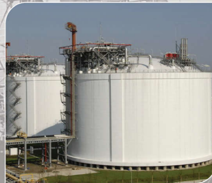
LNG storage tank
